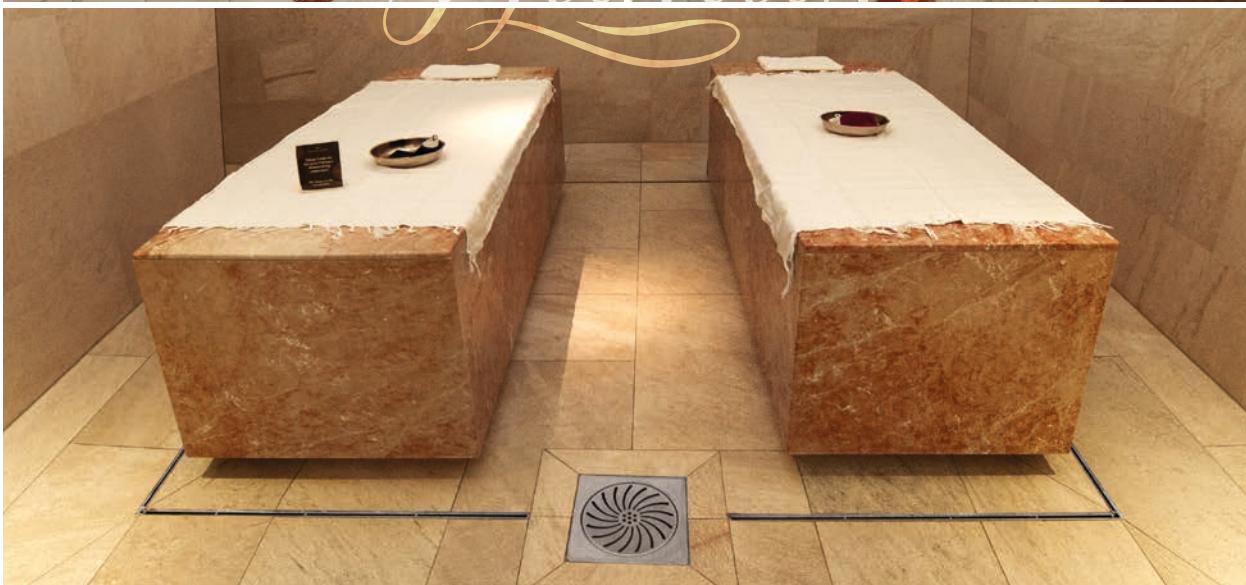
durchlaufende Badrinnenkonstruktion mit Sanitärablauf
